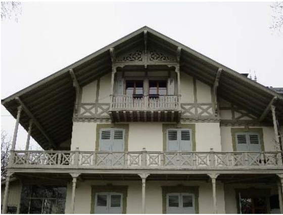
Façade sud, détail
