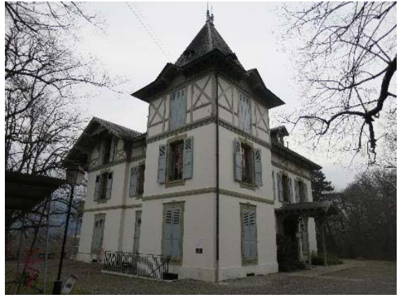
Façades nord et ouest
