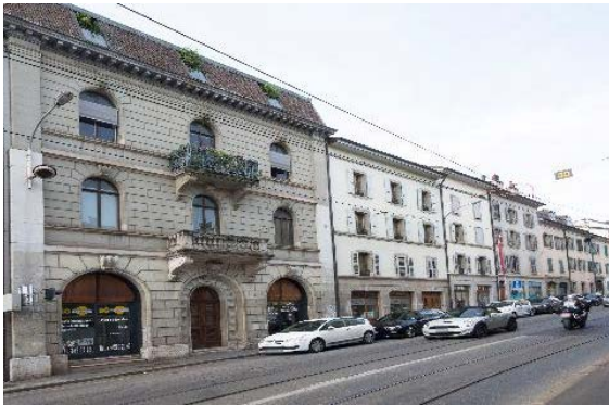
12 à 24, rue de Chêne-Bougeries, vue d'ensemble, façades nord-est
