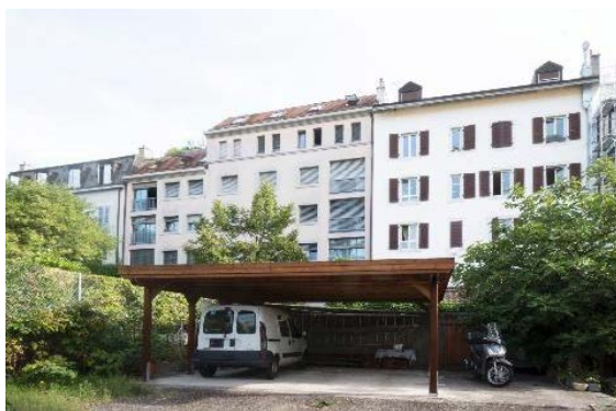
A l'extrémité gauche, façade sud-ouest du 24, rue de Chêne-Bougeries
