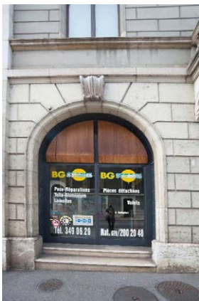
Façade nord-est, détail de baie au rez-de-chaussée
