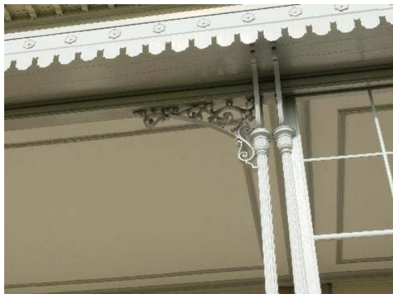
Travail de fer forgé de la véranda, façade est
