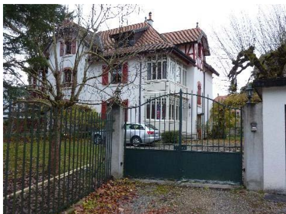
Façades sud-ouest et sud-est, vue depuis le portail d'entrée
