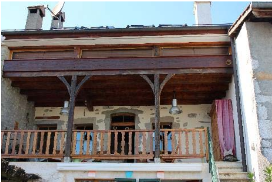
Façade sud-est, détail du balcon couvert
