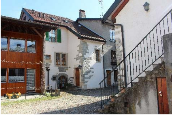
Façade nord-ouest , vue depuis l'entrée de la cour
