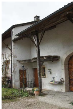
Façade sud-est, structure en bois
