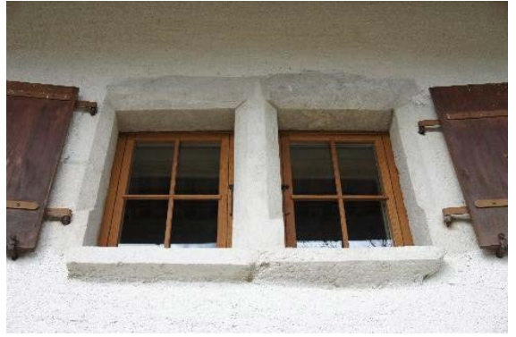
Façade sud-est, fenêtres au premier étage
