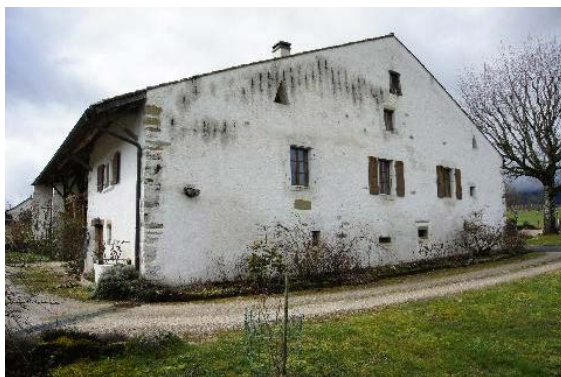
Façades sud-est et nord-est
