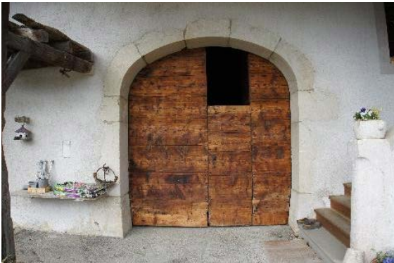
Façade sud-est, porte de grange
