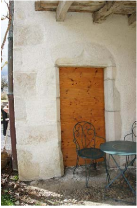
Façade sud-est, porte reliant les nos 10 et 12
