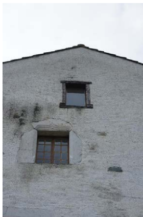
Pignon de la façade nord-est
