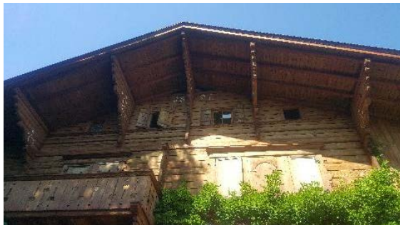
Détail de la façade sud-est
