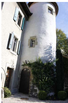
Détail façade sud
