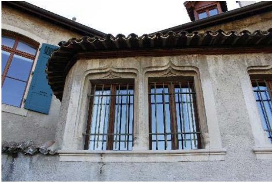
Détail ouvertures à arc en accolade, façade nord
