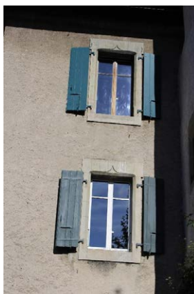
Détail ouvertures à arc en accolade, façade sud
