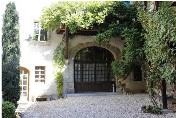
Emplacement de porte de grange à arc en anse de panier, façade sud
