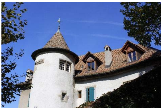
Couverture, façade sud
