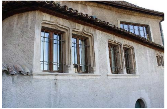
Détail ouvertures à arc en accolade, façade nord
