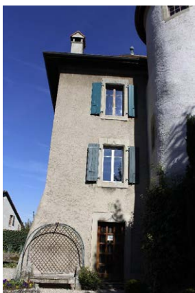
Détail façade sud, tourelle à droite
