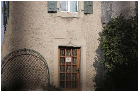
Façade sud, avec pierre armoriée
