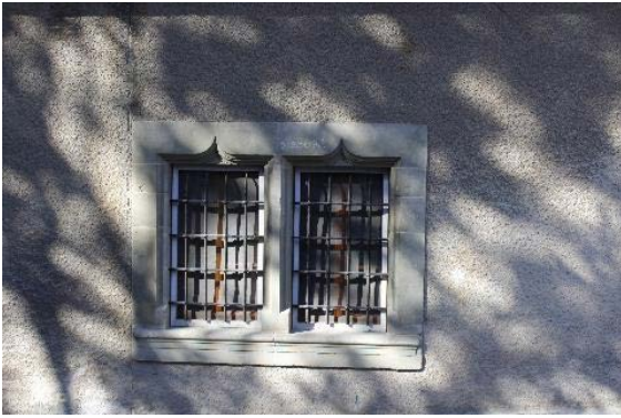
Détail façade nord, ouvertures à arc en accolade
