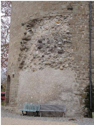
Façade ouest, traces d'arrachement du mur de courtine
