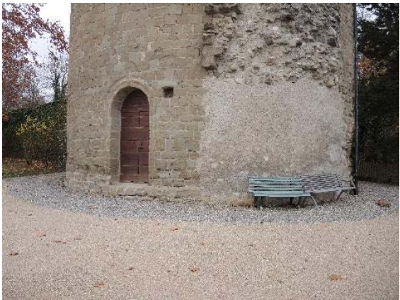
Façade nord-ouest et traces d'arrachement du mur de courtine ouest
