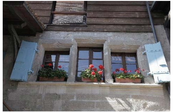
Façade est, baies en triplet à accolades au 1er étage
