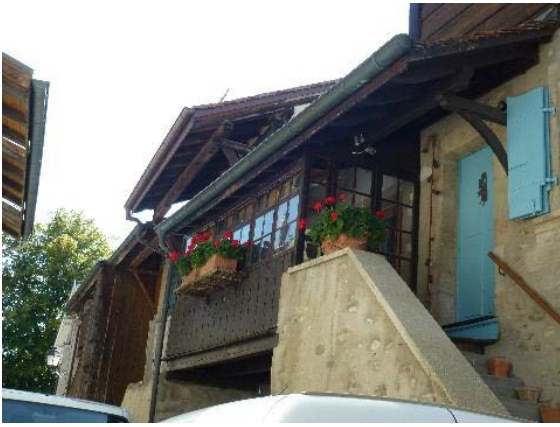
Véranda, façade est
