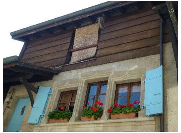
Fenêtre avec linteau à accolade, façade est
