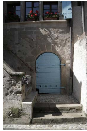
Façade est, porte de "cave"
