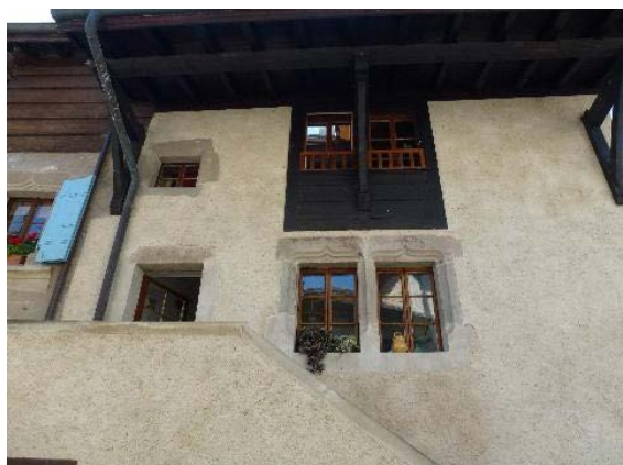
Ouvertures du 1et et 2e étage, façade est
