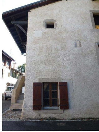
Façade nord, travée est
