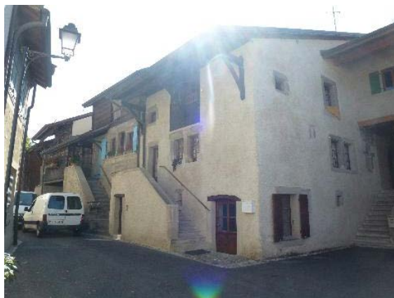
Façades nord et est
