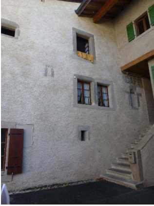
Façade nord, travée ouest
