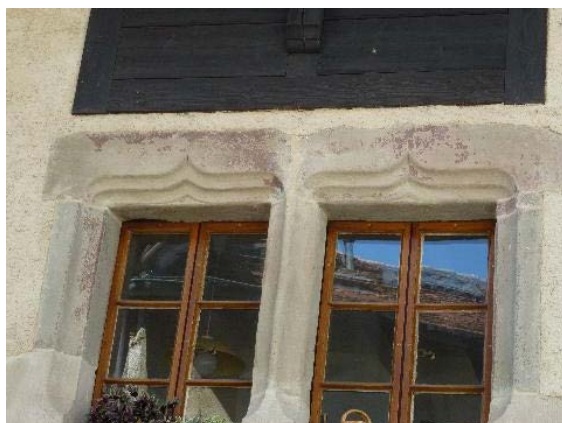
Façade est, baies à linteau avec arc en accolade
