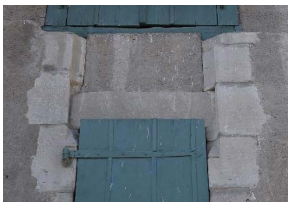
Façade est, détail des vestiges de l'ancienne fenêtre médiévale
