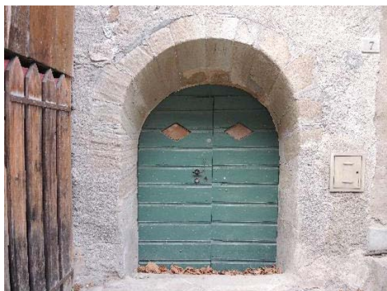
Façade est, entrée
