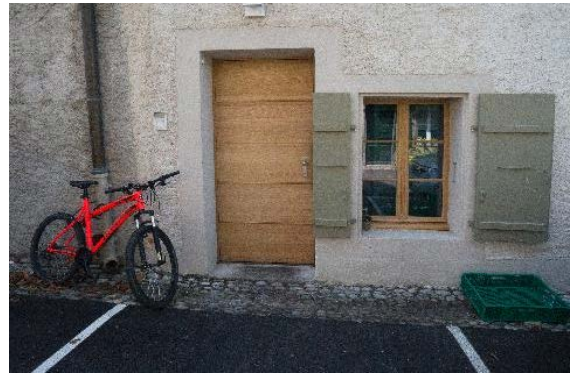
Façade nord, détail de la porte piétonne
