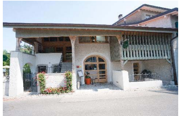
Façade sud (ancienne partie dépendance comprenant à l'origine une grange et une écurie)
