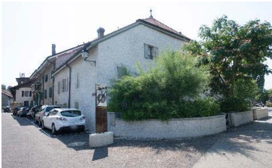
Façades nord et ouest
