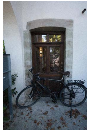
Façade sud, détail de la porte d'entrée
