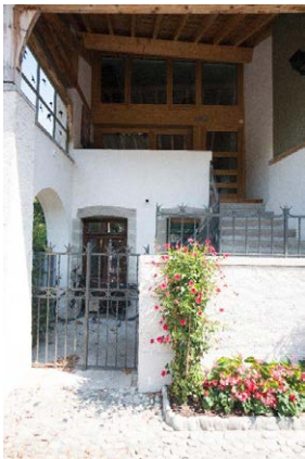
Façade sud, détail de l'entrée, escalier extérieur en molasse
