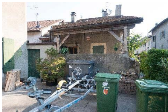
Angle nord-est (bâtiment no 324)
