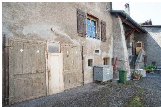
Façade nord, détail de baies, contrefort
