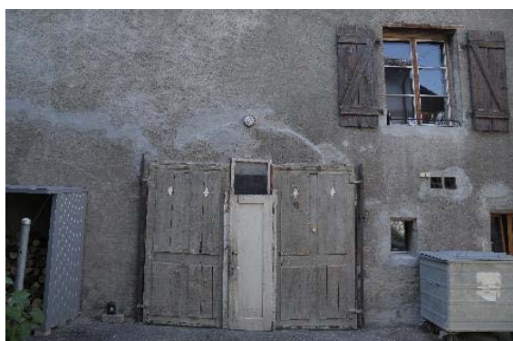
Façade nord, détail du rez-de-chaussée
