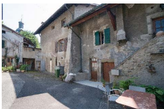
Vue nord-est de la cour (en premier plan chemin)
