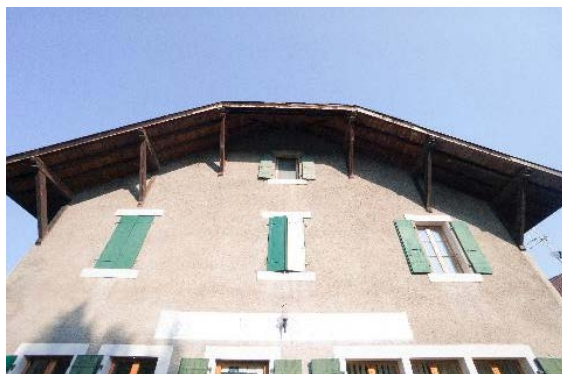
Façade est, détail de l'avant-toit, baies
