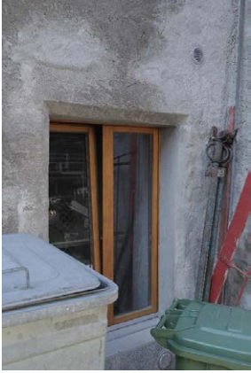
Façade nord, détail de la baie chanfreinée au rez-de-chaussée
