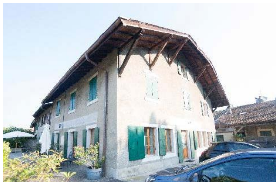
Façades sud et est
