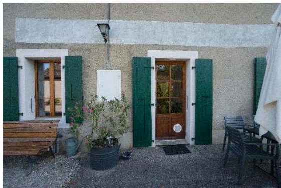
Façade sud, détail de baies
