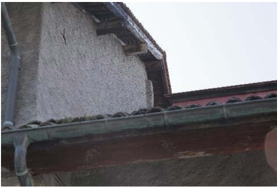
Façade ouest, détail
