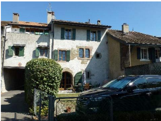
Façade ouest : de gauche à droite, bât. 484 et bât. 783
