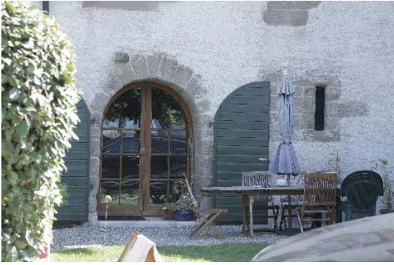
Façade ouest, détail du rez-de-chaussée
