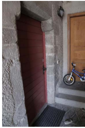
Entrée par la façade nord
