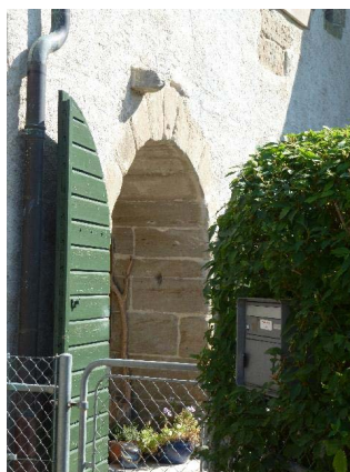
Détail façade ouest, emplacement de porte de grange à arc plein-cintre
