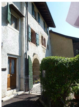
Façade ouest : à gauche, bât. 484 ; à droite, bât. 783
