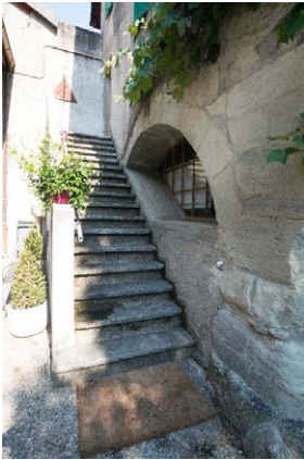
Façade sud, détail de l'escalier extérieur
