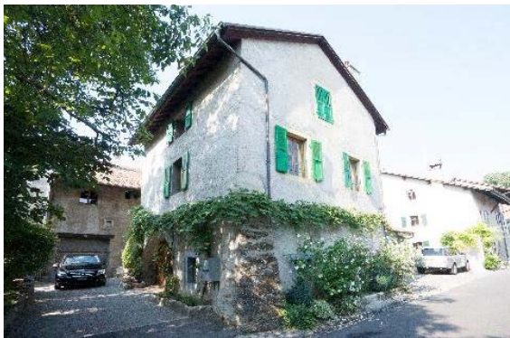
Façades nord et est
