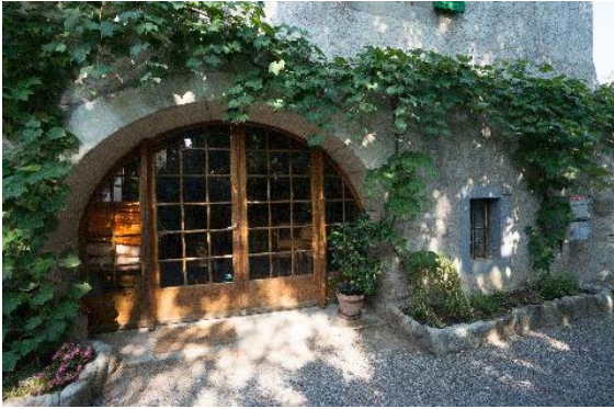
Façade est, détail de baies
