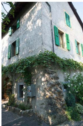
Angle nord-est, détail de baies, contrefort
