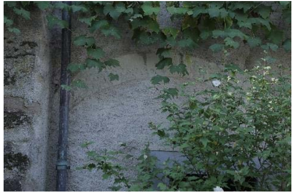
Façade nord, détail de l'arcade bouchée
