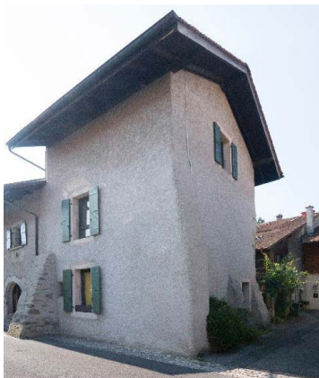
Façades nord et ouest
