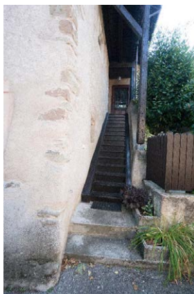
Façade sud, entrée, escalier extérieur
