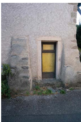
Façade pignon ouest, détail de baie, contreforts
