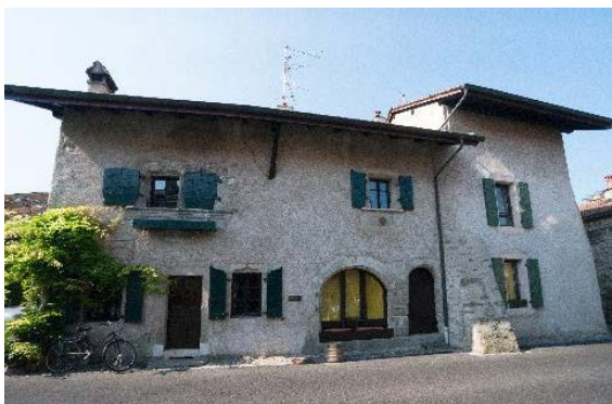
Façade nord (rue du Midi 27-31)
