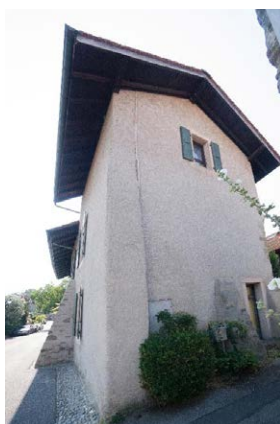
Façade pignon ouest
