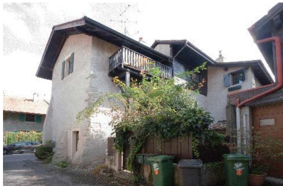
Façades sud et ouest (rue du Midi 27-31)
