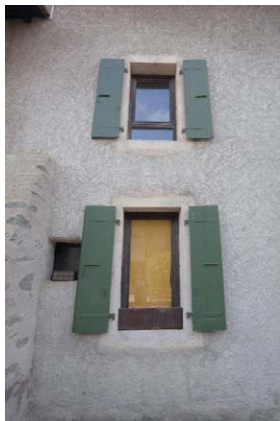
Façade nord, détail de baies
