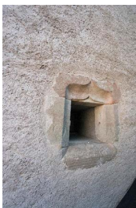
Façade sud, détail de baie, crépi
