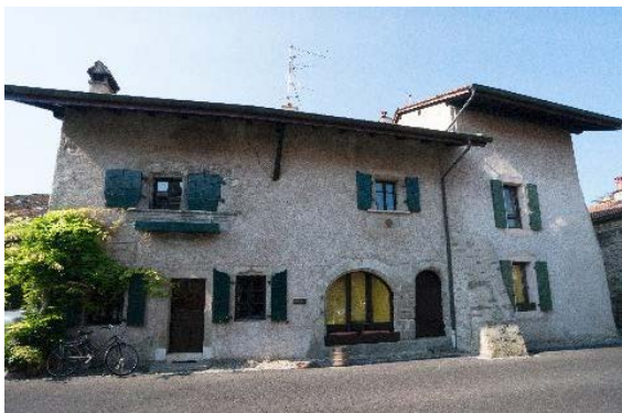
Façade nord (Rue du Midi 27-31)
