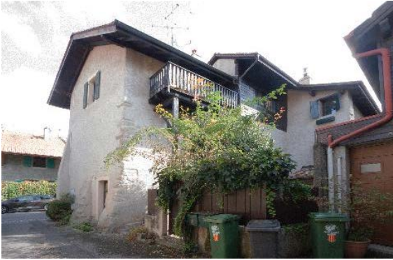
Façades sud et ouest (rue du Midi 27-31)
