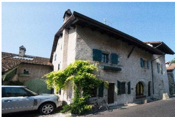
Façades nord et est (Rue du Midi 27-29)
