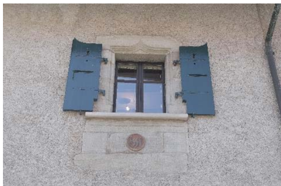
Façade nord, détail
