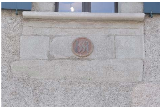
Façade nord, détail
