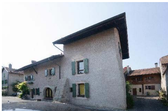
Façades nord et ouest (rue du Midi 27-31)
