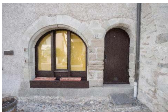
Façade nord, détail de baies au rez-de-chaussée
