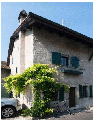
Façades nord et est
