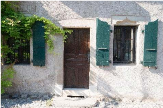
Façade nord, détail de l'entrée
