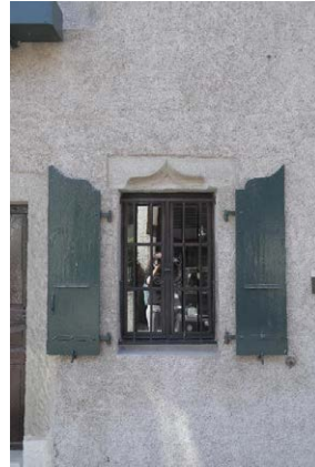
Façade nord, détail d'une fenêtre au rez-de-chaussée
