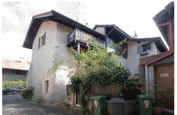
Façades sud et ouest (rue du Midi 27-31)
