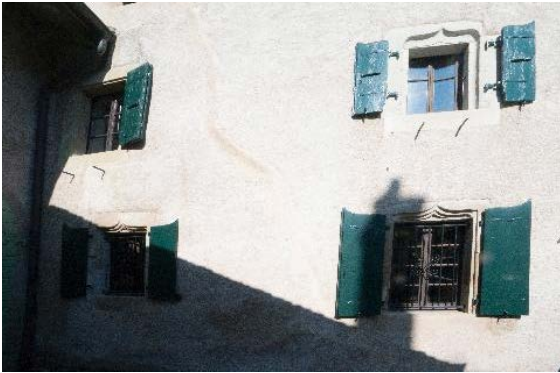
Façade est, détail de baies
