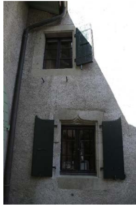
Façade est, détail des encadrements des fenêtres
