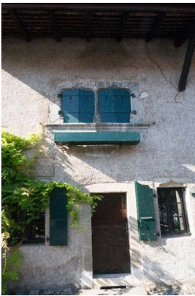
Façade nord, détail de l'avant-toit, baie géminée au premier étage
