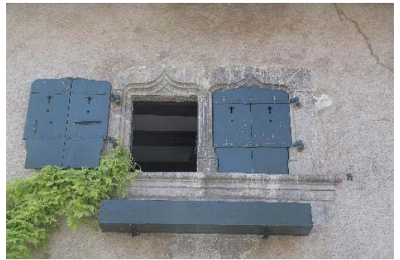
Façade nord, détail des fenêtres du 1er étage
