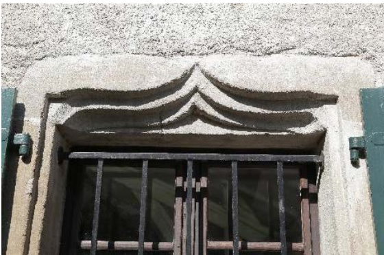
Façade est, détail de l'encadrement d'une baie
