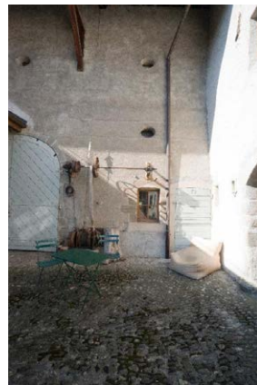
Façade sud (bâtiment no 874), détail
