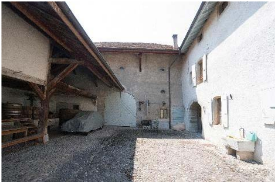
Façades sud, est et ouest (à droite bâtiment no 86 et en arrière-plan l'ancienne grange (bâtiment no 874))
