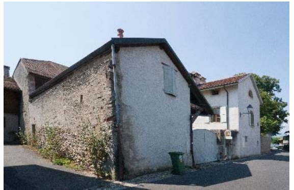
Façades nord et est (bâtiments nos 86 et 87)
