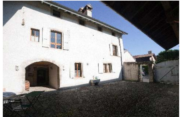
Façade est vue vers l'entrée
