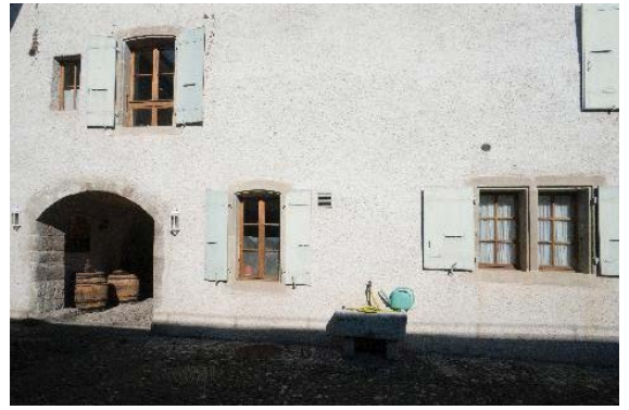
Façade est, détail de baies
