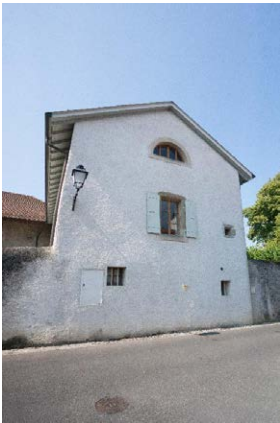
Façade nord, ancienne écurie (bâtiment no 86)
