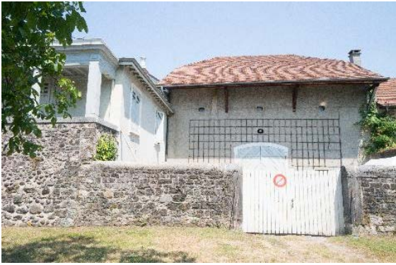
Façades sud et est (bâtiments nos 477 et 874)
