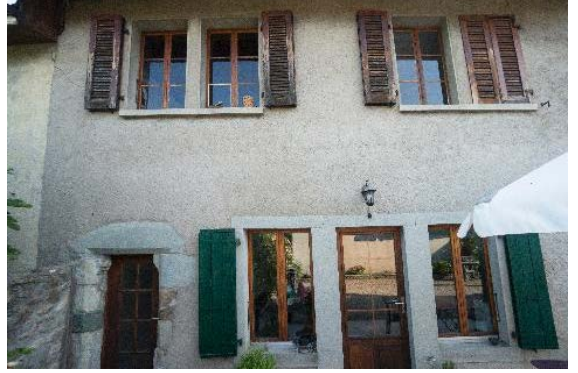
Façade sud, détail de baies
