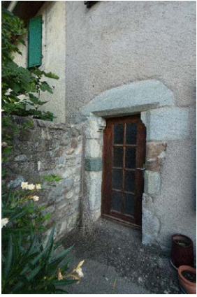
Façade sud, détail de baie
