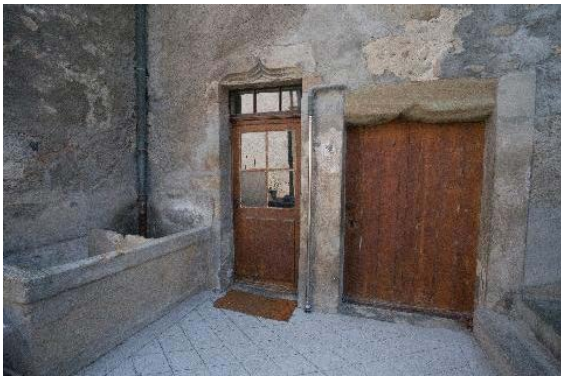
Façade nord, détail de l'entrée, bassin
