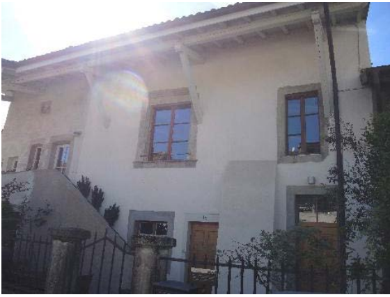
Nord 13-15, façades nord
