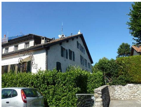
Façades est et sud
