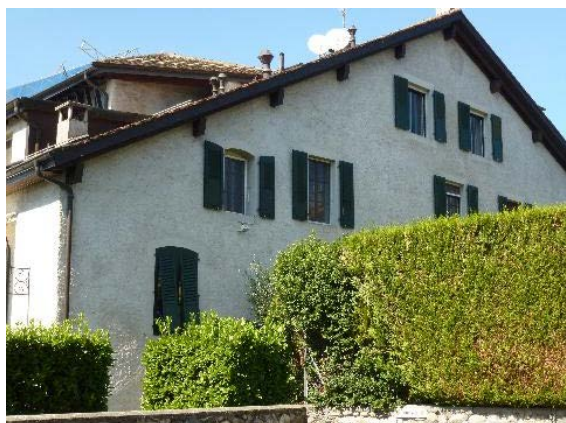
Façade pignon est
