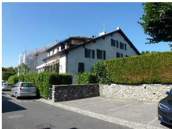
Façades est et sud
