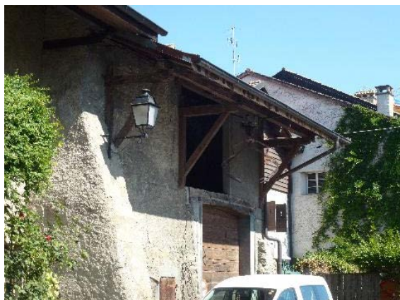
Avant-toit façade sud-ouest
