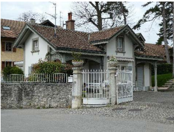
Loge, façades sud et est
