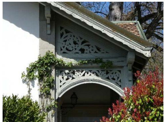
Loge, façade sud, détail bras de force
