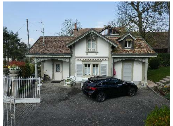
Loge, façade est
