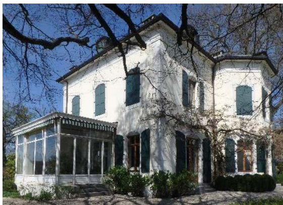
Façades sud-ouest et sud-est
