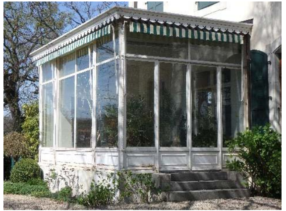
Façade sud-ouest, détail (véranda)
