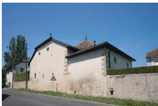
Façades sud et est (bâtiment no 20)
