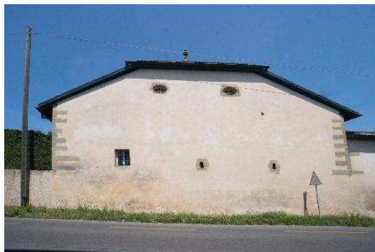
Mur pignon sud
