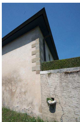
Angle sud-est, détail de l'avant-toit et de la chaîne
