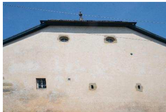
Mur pignon sud, détail de baies
