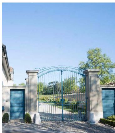
Entrée, détail du portail en fer forgé
