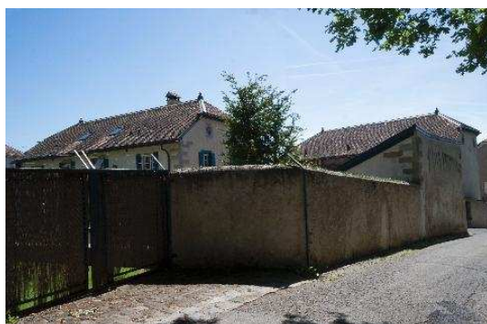
Façades nord et ouest (chemin Jacques-Rutty 4B et bâtiment no 1207)
