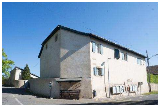
Façades sud et ouest
