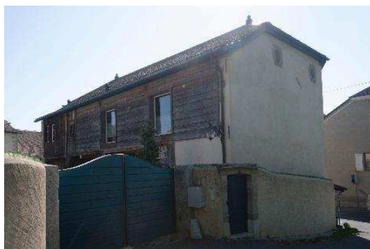
Façades nord et ouest
