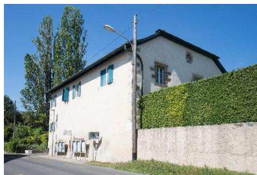
Façades sud et est
