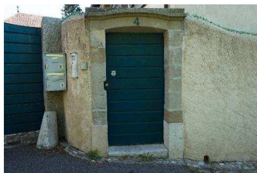
Angle nord-ouest, entrée
