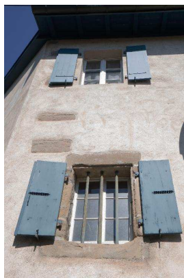
Façade sud, détail de baies
