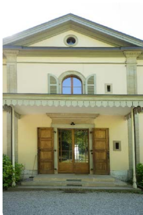
Façade nord, baies, fronton, détail de l'entrée
