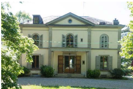
Façade nord, détail
