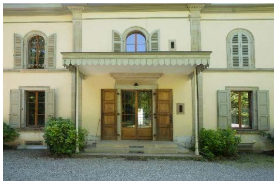
Façade nord, détail de baies
