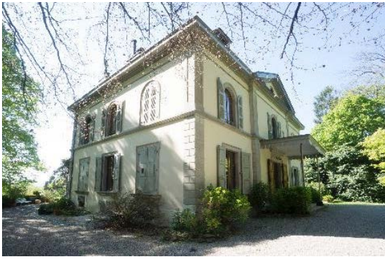
Façades nord et est
