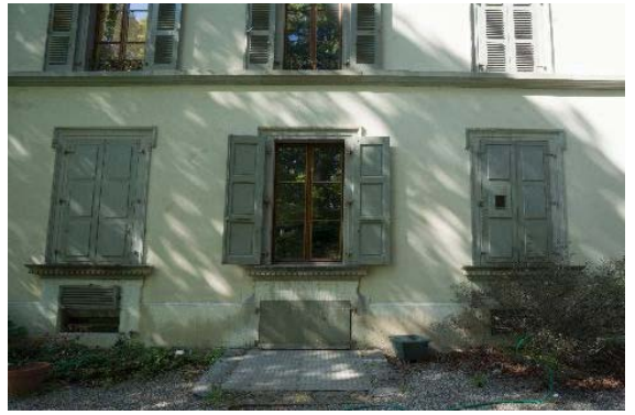
Façade est, détail de baies
