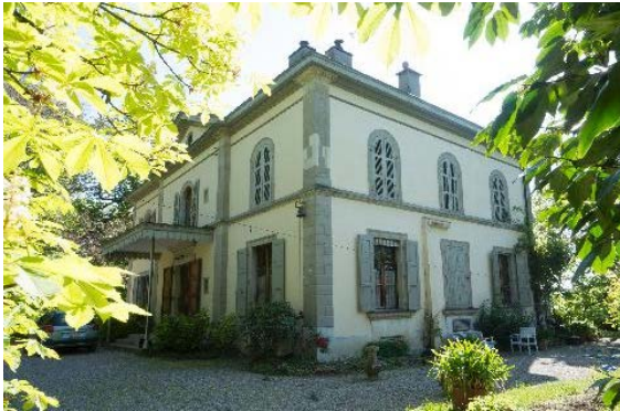
Façades nord et ouest
