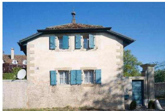
Façade sud (bâtiment no 24)
