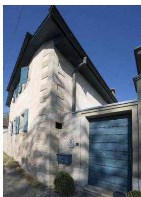
Angle sud-est, baies, chaîne d'angle, détail
