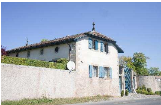
Façades sud et ouest (bâtiment no 24)
