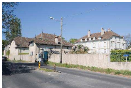
Façades sud et est (domaine Chougny-Fontaine)
