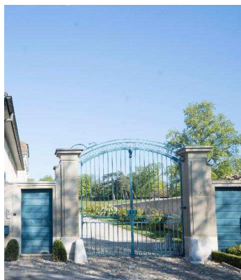
Entrée, détail du portail en fer forgé
