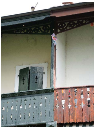
Anémones 4-2, façades sud-ouest, détail boiseries
