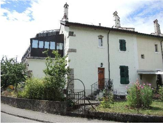
Anémones 2 et De-Maisonneuve 25, façades sud-est et nord-est, depuis chemin De-Maisonneuve
