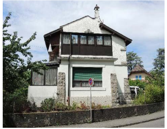
Bât. 2737, façade sud-est, depuis chemin De-Maisonneuve
