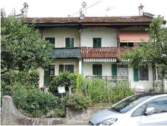
Anémones 4-2, façades sud-ouest
