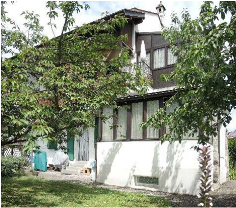
Bât. 2737, façade sud-ouest
