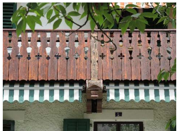
Façade sud-ouest, détail boiseries du balcon
