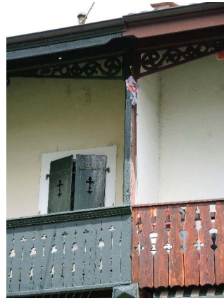
Anémones 4-2, façades sud-ouest, détail boiseries
