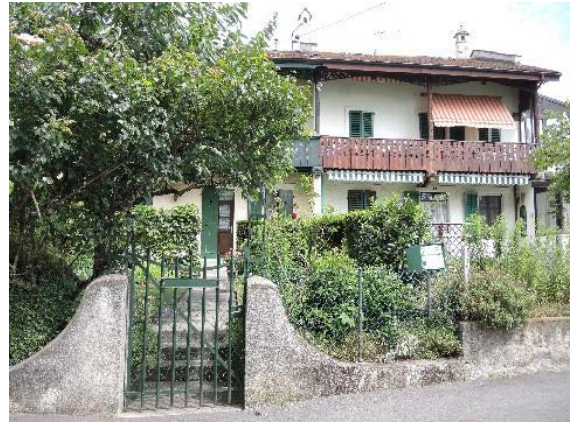
Portail d'entrée, Anémones 4 (gauche), et Anémones 2 (droite), façades sud-ouest
