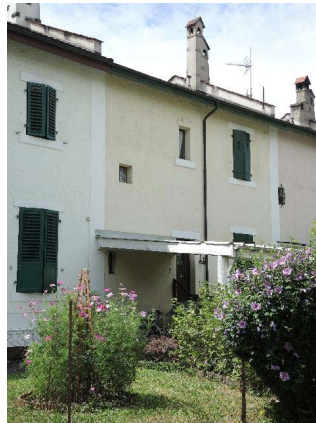
Façade nord-est (entre De-Maisonneuve 25 et 27), depuis chemin De-Maisonneuve
