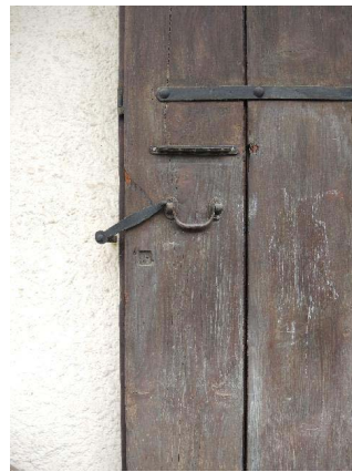
Façade sud-ouest, détail volet
