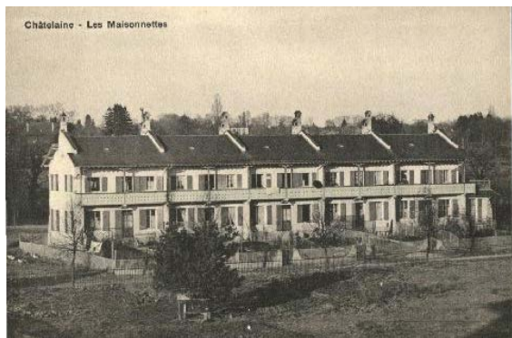
Anémones 2 (droite) à 10 (gauche), vue d'ensemble, façades ouest et sud
