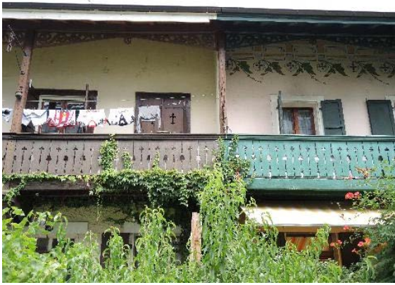
Anémones 8 et De-Maisonneuve 27, façades sud-ouest
