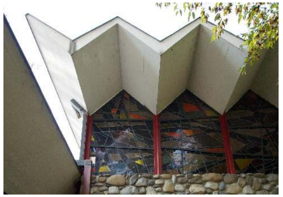
Détail, toiture et vitraux
