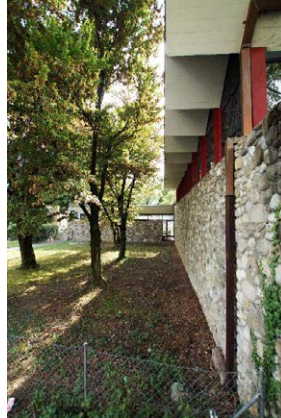
Détail, murs latéraux
