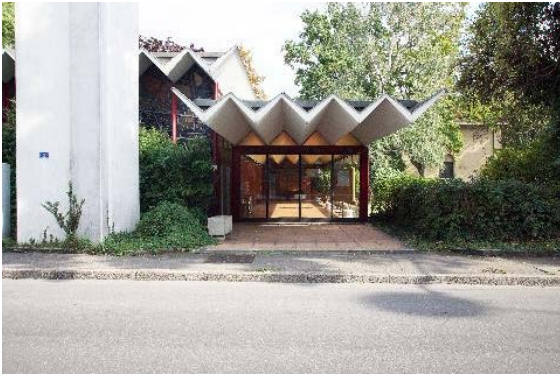
Façade ouest, détail, porche d'entrée, toiture
