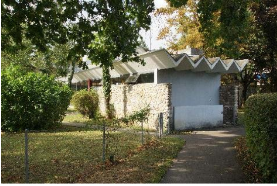
Façade sud-est, détail
