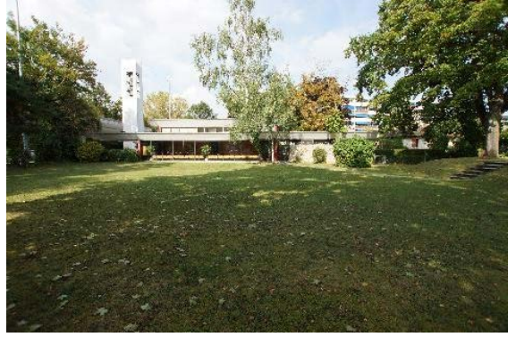
Façade sud, détail, jardin
