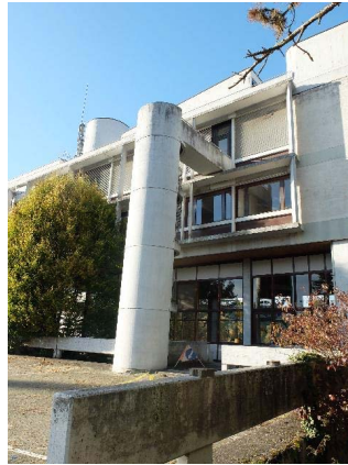
Façade sud, détail sur la cage d'escalier
