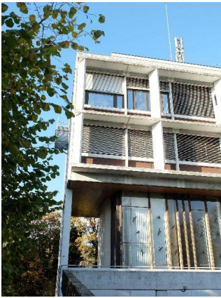
Façade sud, détail
