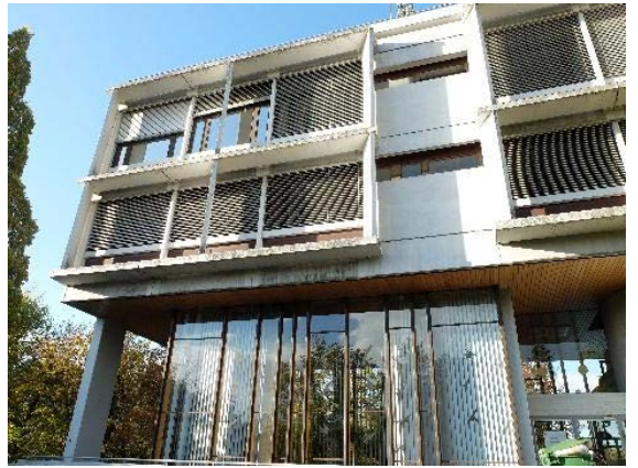
Façade sud, détail
