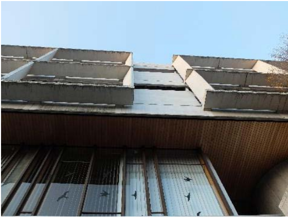
Façade sud, détail
