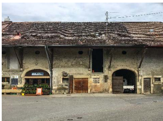
Façade sud-est, détail
