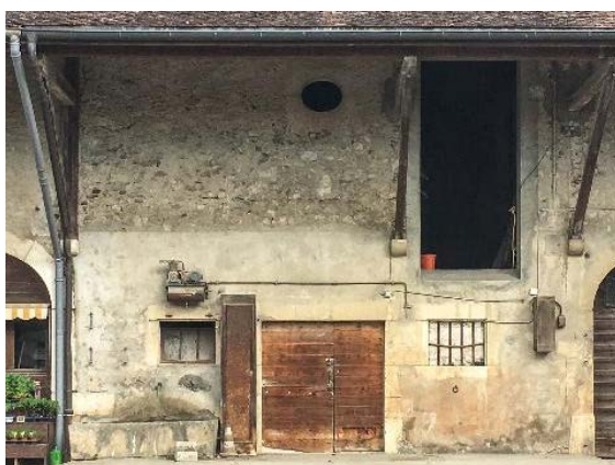
Façade sud-est, détail d'une travée
