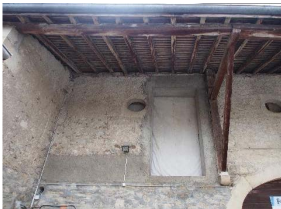
Parties agricoles (bât. 196, 876, 878), façade sud-est: travée de gauche, détail étage
