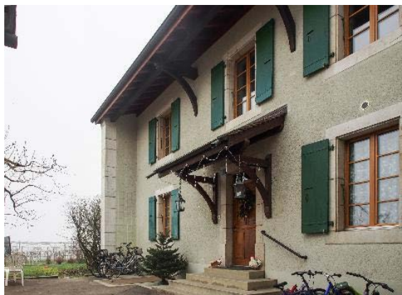
Corps de logis (bât. 211): façade sud-est
