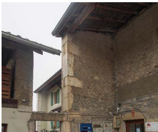
Parties agricoles (bât. 196, 876, 878), façade sud-est: mur coupe-vent gauche
