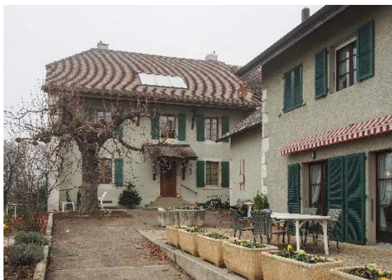
Corps de logis (bât. 211): façade sud-est. A droite, Bravaude 13 (bât. 2722)
