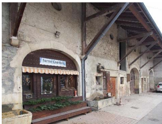
Parties agricoles (bât. 196, 876, 878), façade sud-est: partie droite
