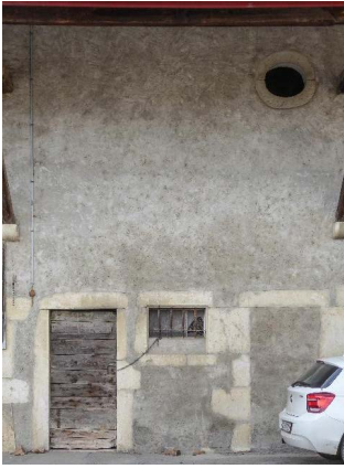
Façade sud-est, détail
