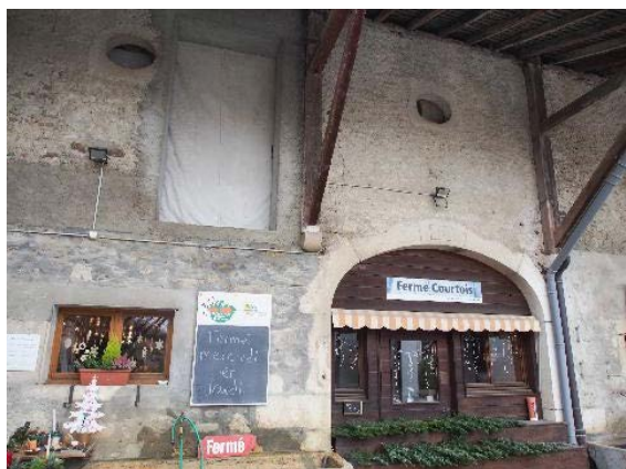
Parties agricoles (bât. 196, 876, 878), façade sud-est: travée centrale
