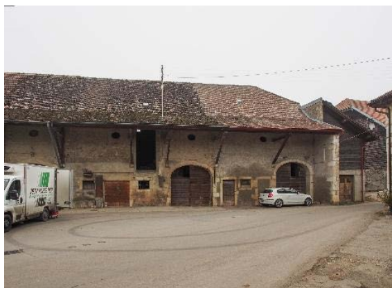
Parties agricoles (bât. 196, 876, 878), façade sud-est:
