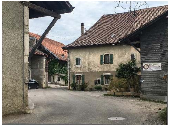
Vue de la cour de ferme depuis le sud avec l'ancienne maison forte au centre
