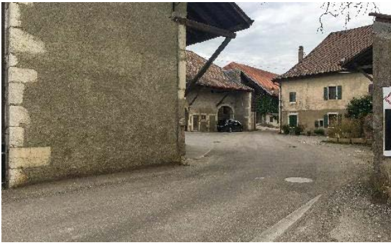
Branvaude 13 (gauche), 11 (centre gauche), 16-20 (centre droit), vue d'ensemble depuis le sud
