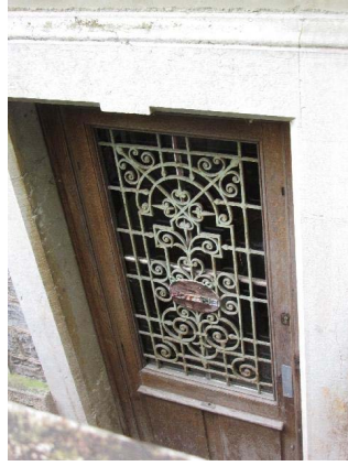
Façade nord-est, soubassement, détail entrée de service
