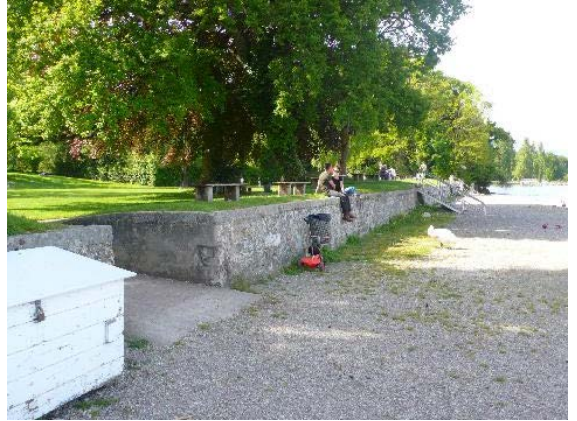
Mur à front de lac et grève
