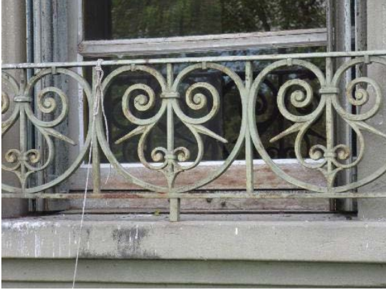
Façade sud-est, rez-de-chaussée, détail garde-corps fenêtre
